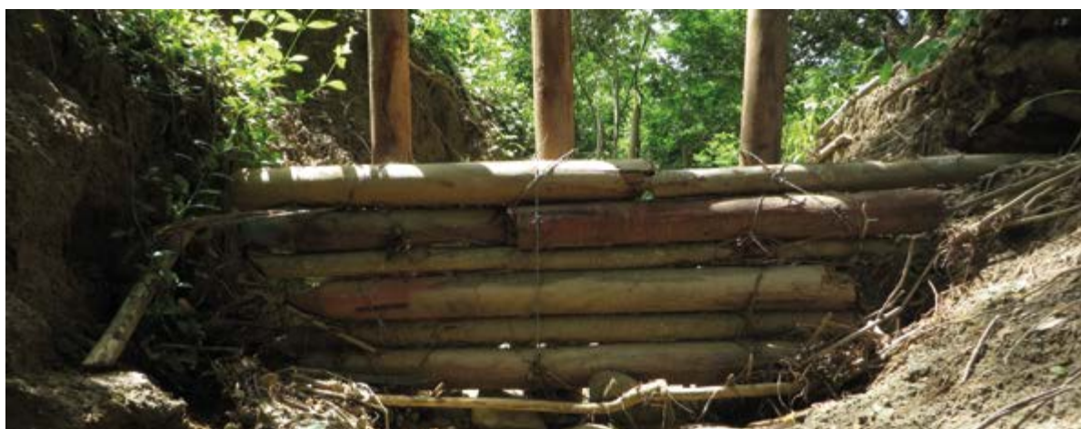
Figuras 34 y 35. Estructuras para contención de suelo. Hibácharo, Atlántico Fotos: Javier Ceballos y Jesús Castillo
